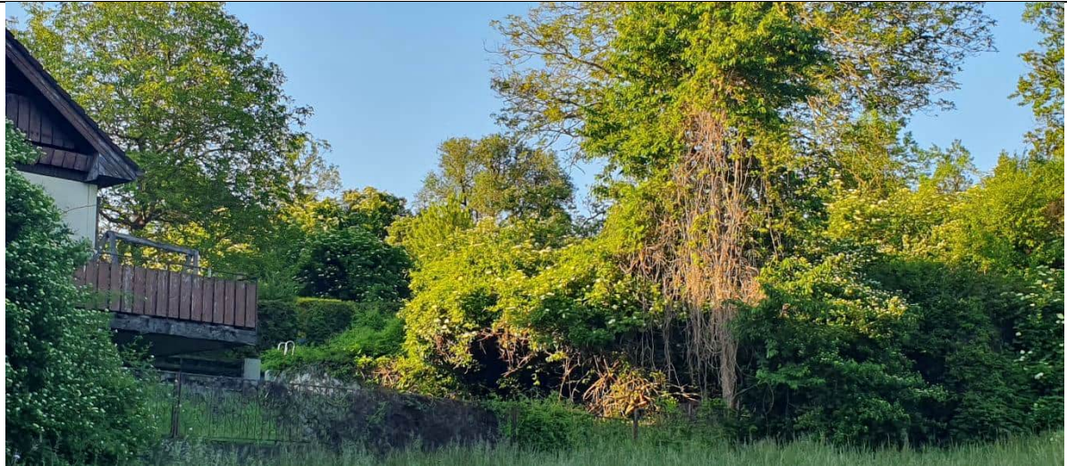
Blick auf das Grst. Nr. 215/9 vom Norden aus
