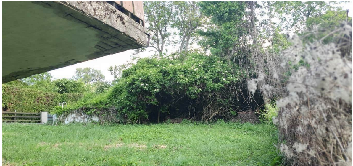
Blick auf das Grst. Nr. 215/9 vom Norden aus
