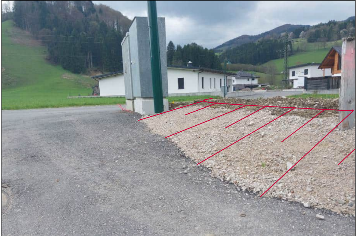
Abbildung 4: Detailansicht der Anschüttung (Geländeadaptierung) (Stand: 16.4.2026)
