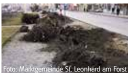
Foto: Marktgemeinde St. Leonhard am Forst
