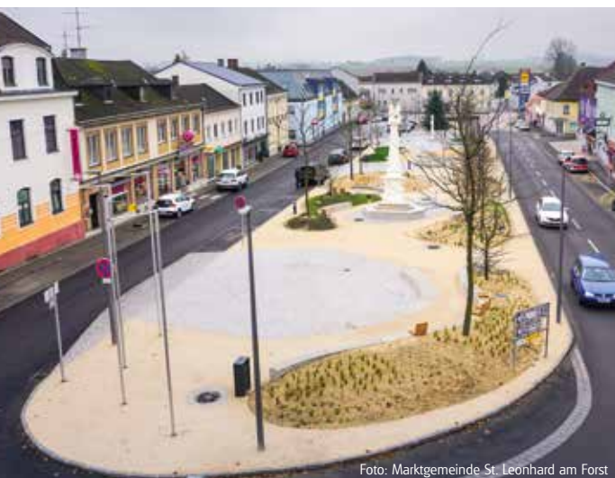
Foto: Marktgemeinde St. Leonhard am Forst
