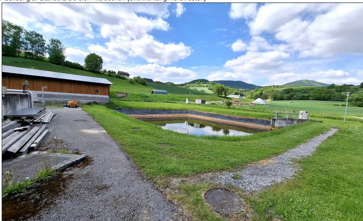
Abbildung 2: Standort, Bereich Klärbecken (Blickrichtung Nordwesten)
