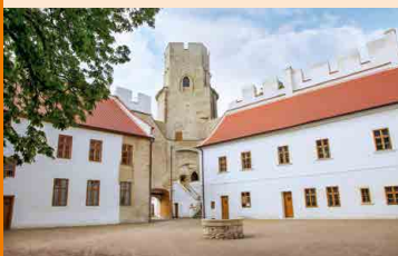
Burg Laa: neu renovierter Innenhof
